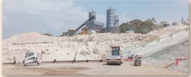
Κατασκευή σκληρού επιχώματος φράγματος Καμμίτση.
