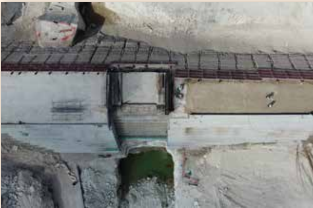
Πανοραμική άποψη φράγματος Αρχαγγέλου.
