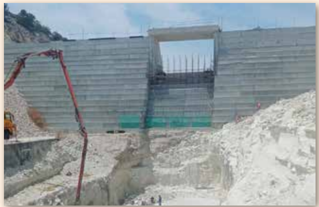
Υπερχειλιστής φράγματος Αρχαγγέλου.
