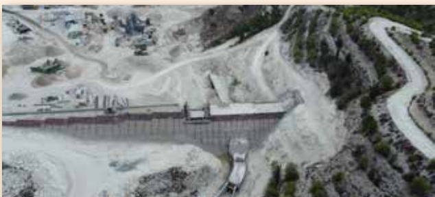
Πανοραμική άποψη φράγματος Αρχαγγέλου.
